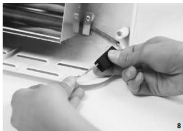
8. INTRODUCEȚI NOILE FASTONS ȘI FIXAȚI-LE DE FIR.
